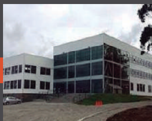
Colegio Instituto Técnico Alerce Cordillera
